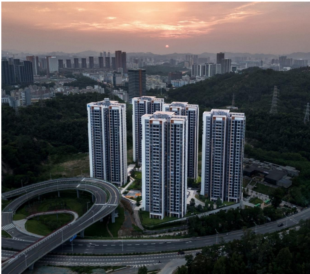
项目全景航拍
