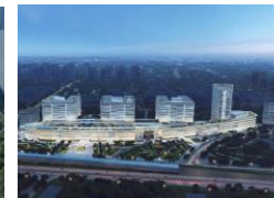
深圳市人民医院宝安医院 超低能耗建筑、双碳建筑
